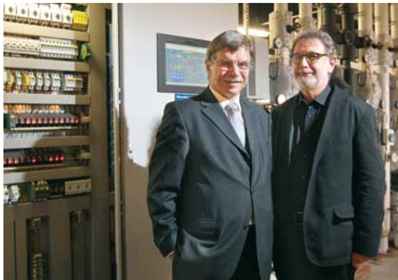
Fast 5000 Tonnen Kohlendioxid im Jahr gespart: DIAKO-Vorstand Karl-Heinz Vorwig und Technischer Leiter Fritz Petersen vor modernster Technik der „Klima-Zentrale 3“ des Diakonissenkrankenhauses.
